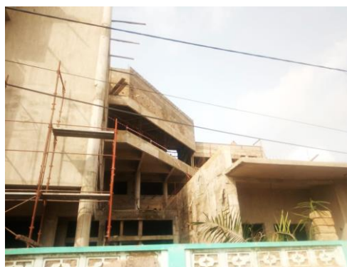
Planche 2 : Vue partielle du nouveau bâtiment de la Mairie. Plus conforme aux normes, ce nouvel édifice offrira un cadre plus adéquat à la conservation des archives.
